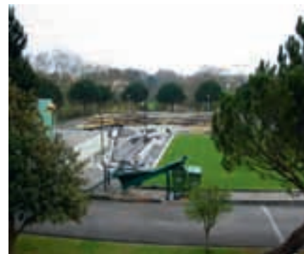
ETAR da Ponte de Moreira
