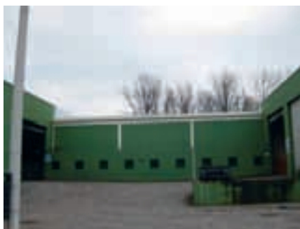
Estação de Compostagem de Lamas: 20 ton/dia de lamas tratadas
